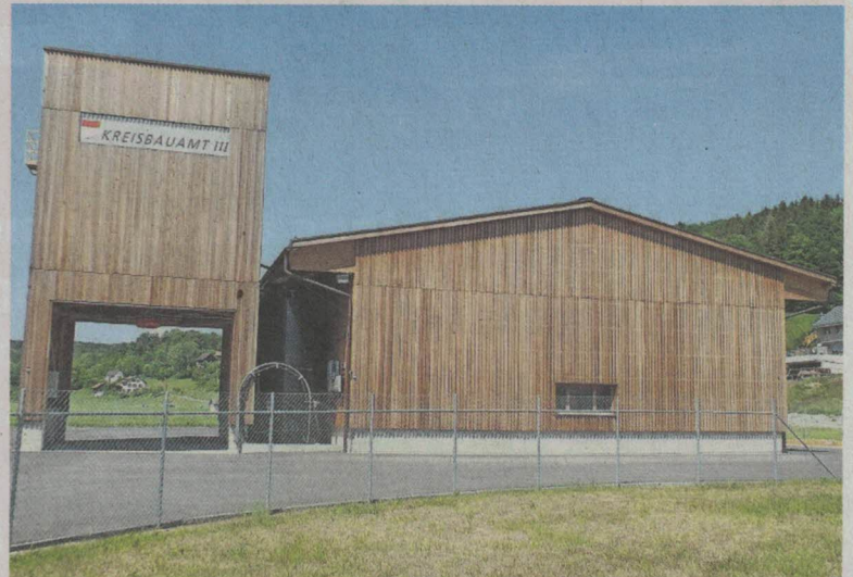
Vorbildlich: Der Werkhof des Kreisbauamts III des Kantons Solothurn in Seewen ist ein Vorzeigebau in Bezug auf Schweizer Holz.
